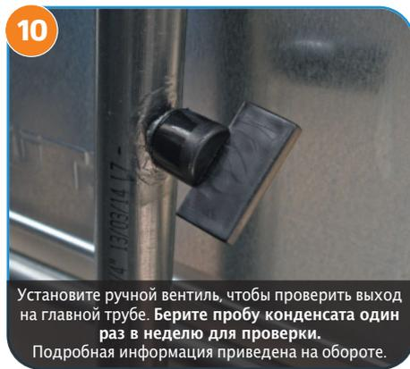
10 Установите ручной вентиль, чтобы проверить выход на главной трубе. Берите пробу конденсата один раз в неделю для проверки. Подробная информация приведена на обороте.
