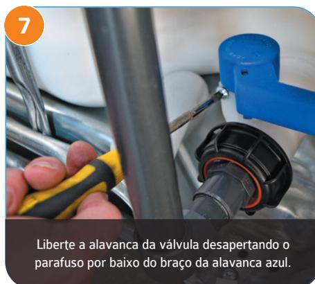
7 Liberte a alavanca da válvula desapertando o parafuso por baixo do braço da alavanca azul.
