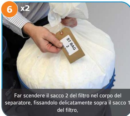
6 x2 Far scendere il sacco 2 del filtro nel corpo del separatore, fissandolo delicatamente sopra il sacco 1 del filtro,
