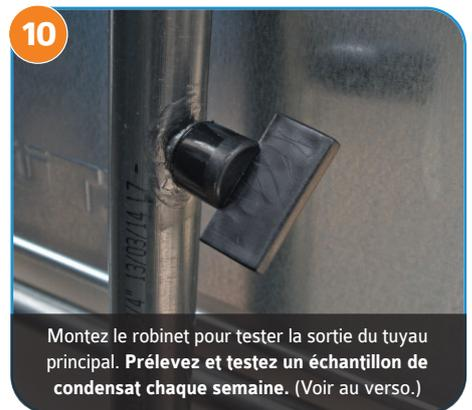
10 Montez le robinet pour tester la sortie du tuyau principal. **Prélevez et testez un échantillon de condensat chaque semaine.** (Voir au verso.)
