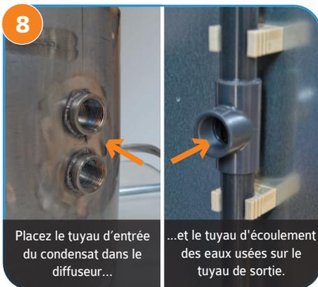
8 Placez le tuyau d'entrée du condensat dans le diffuseur...
