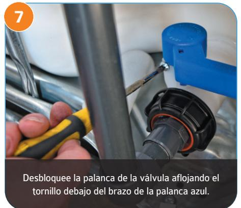
7 Desbloquee la palanca de la válvula aflojando el tornillo debajo del brazo de la palanca azul.
