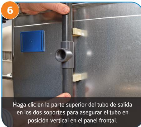
6 Haga clic en la parte superior del tubo de salida en los dos soportes para asegurar el tubo en posición vertical en el panel frontal.
