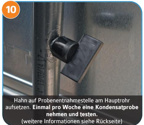
10 Hahn auf Probenentnahmestelle am Hauptrohr aufsetzen. **Einmal pro Woche eine Kondensatprobe nehmen und testen.** (weitere Informationen siehe Rückseite)
